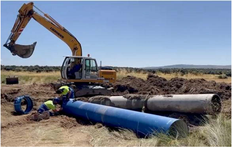
Trabajos con las tuberías.
