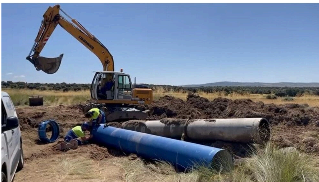
Recarga de la tubería averiada para comprobar su resistencia
