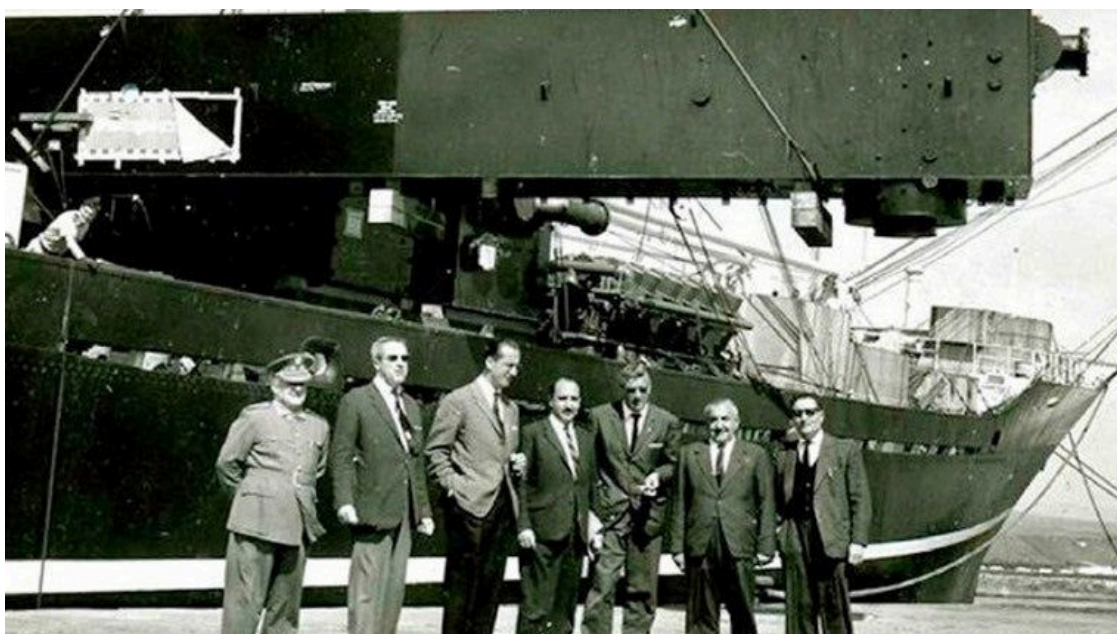
En 1964 llegaron desde Guantánamo los equipos y la maquinaria para construir la primera desaladora de Europa en Lanzarote
