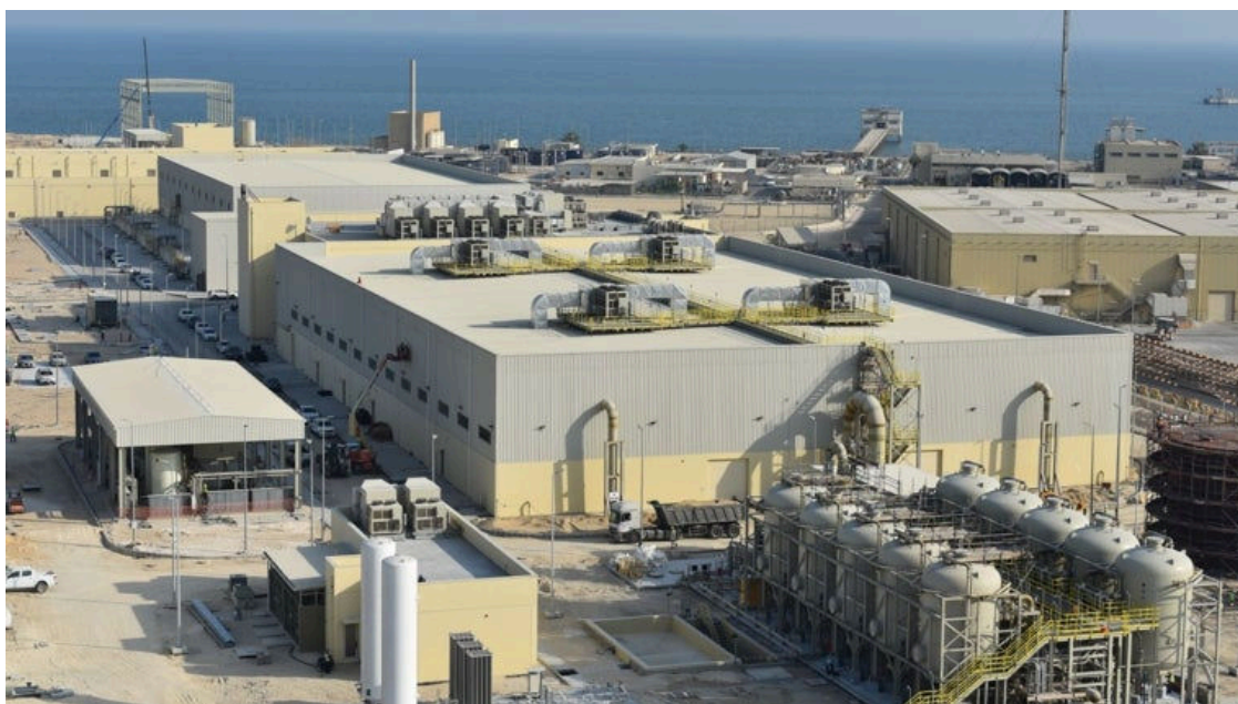
Desaladora de Acciona en Al Khobar es una de las mayores de Arabia Saudí
