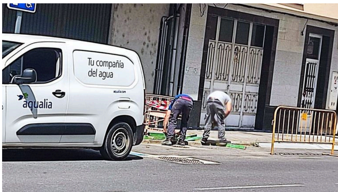
Preparativos para el inicio de las obras en la calle Escultor Francisco Moure cedida
