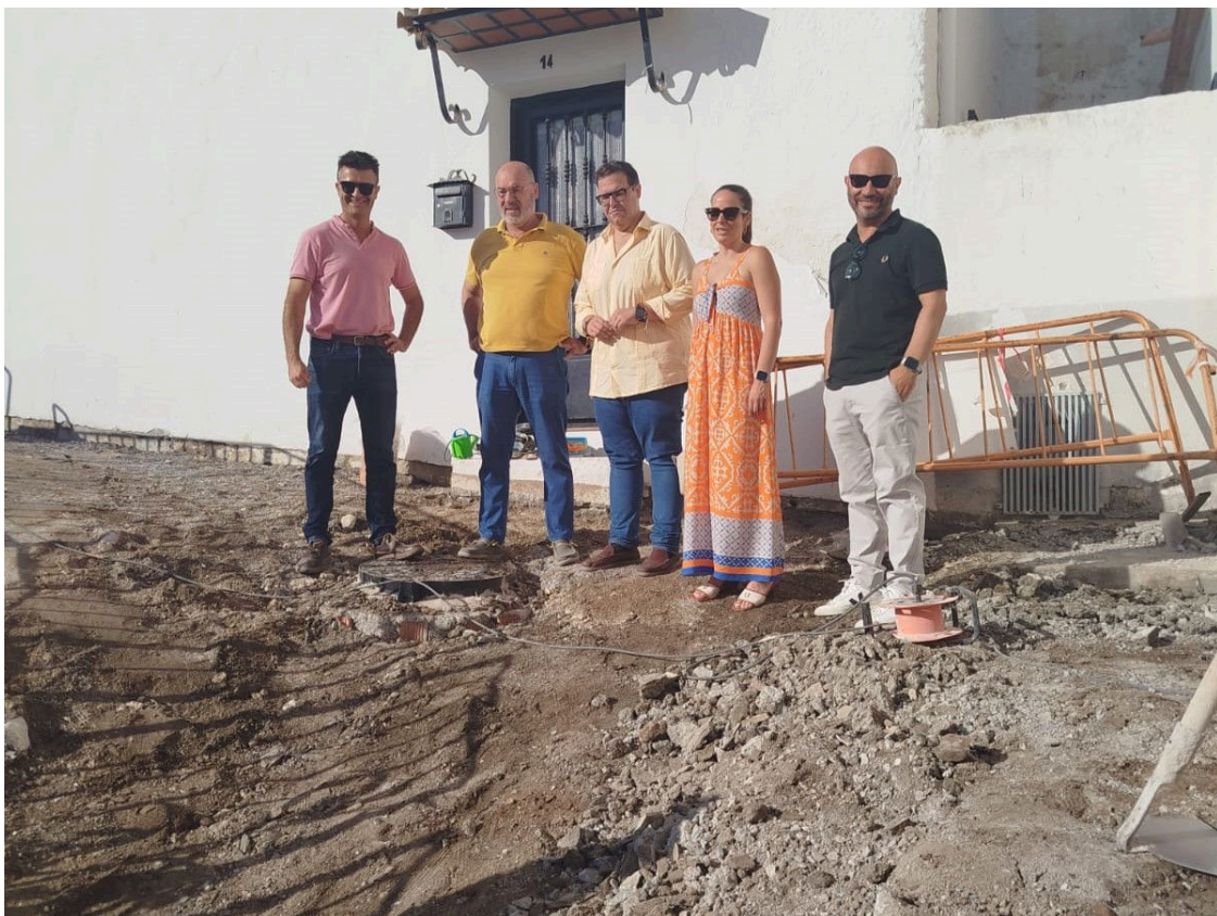
Visita de autoridades y técnicos a las obras de la calle Girasol de la Caleta de Salobreña (EL FARO)
