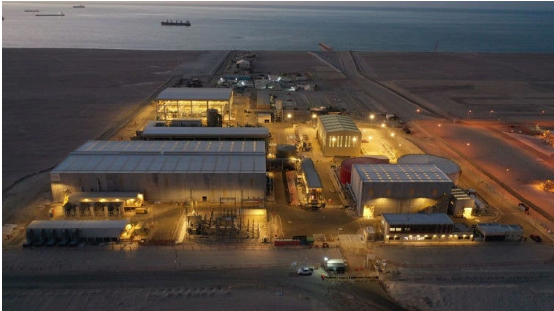
Planta de desalación de Tedagua para Mina Spence (Chile)
