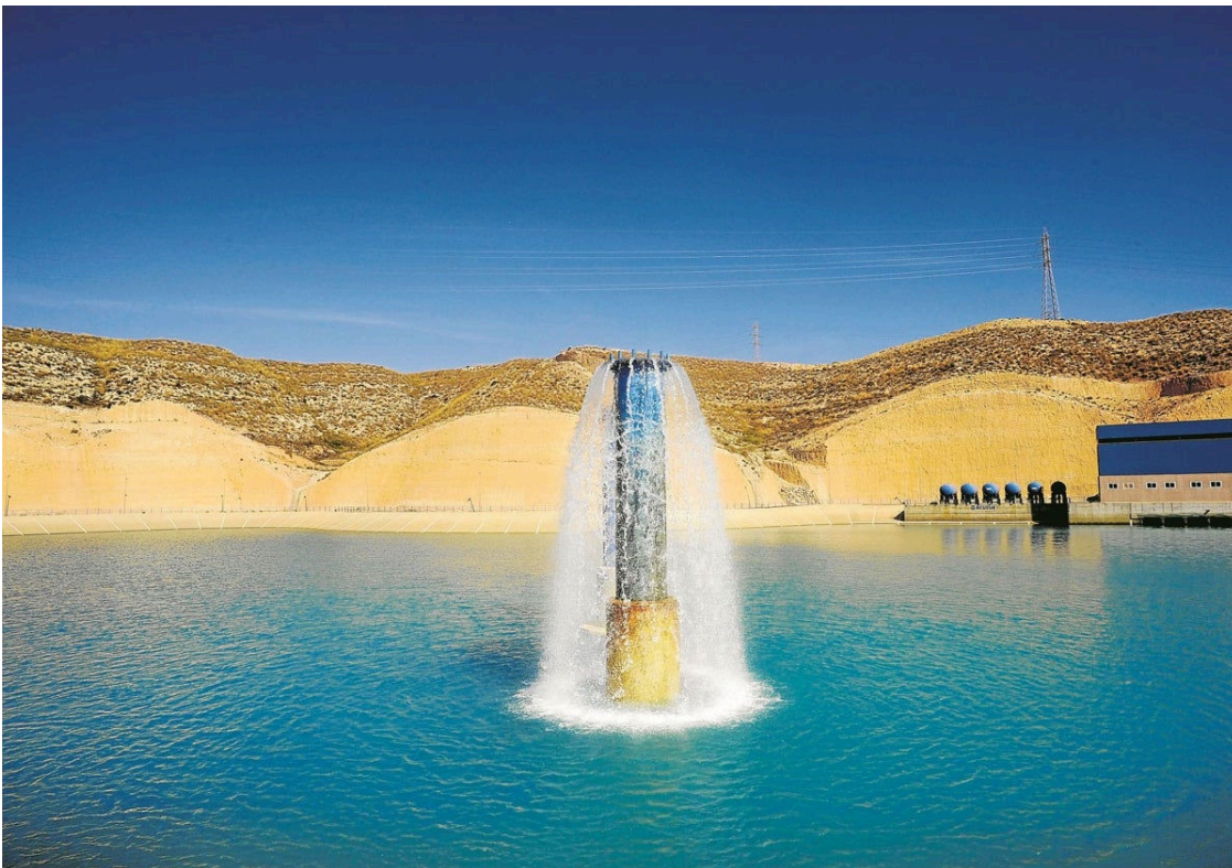
El agua desalada es bombeada a un depósito en la planta de Carboneras (Almería)
