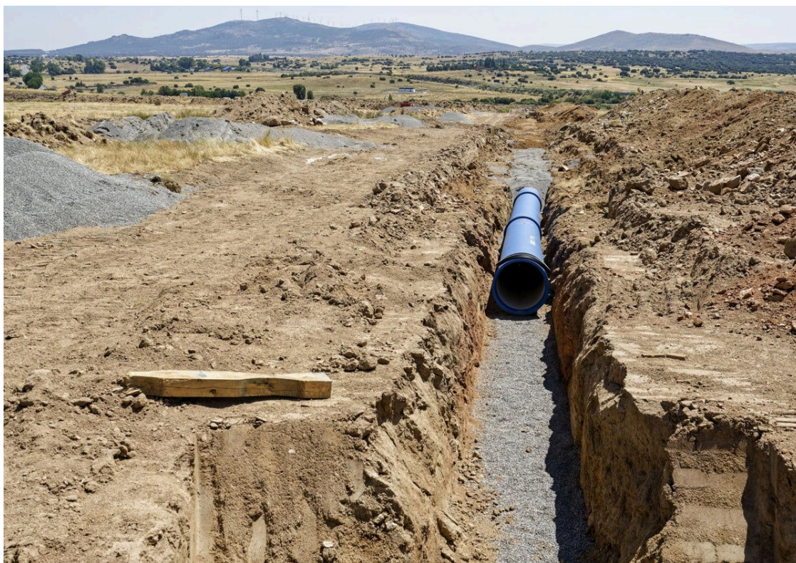
Reparación de la tubería de 20 kilómetros que une el embalse de Serones y la Estación de Tratamiento de Agua Potable (ETAP) y que ha mantenido a Ávila sin agua
