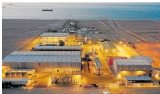
Planta de desalación de Tedagua para Mina Spence (Chile)
