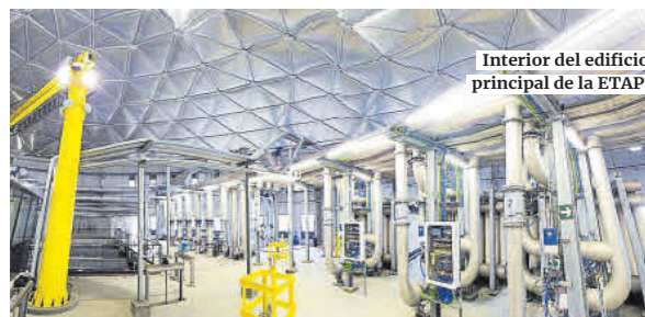
Instalación de microfiltración.
